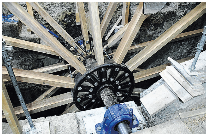
Die Hauptachse des alten Wasserrads, sandgestrahlt und mit den neuen Armen aus Eichenholz verschraubt, liegt perfekt im neuen Lager.
