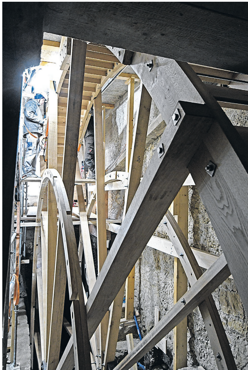
Das Radhaus ist eigentlich nicht klein, beim Einbau des Wasserrads mit 9,6 Metern Durchmesser wird es dann doch etwas eng.
