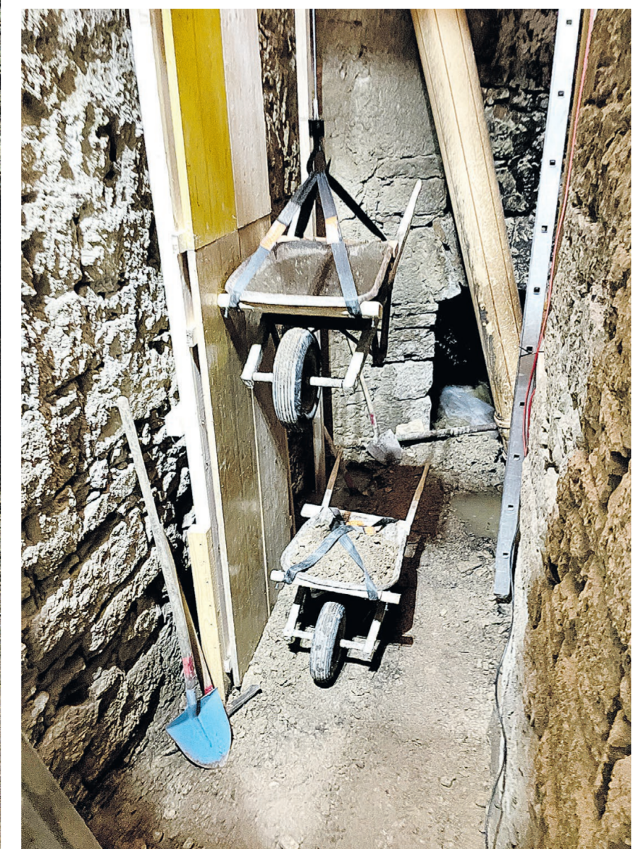
Mithilfe einer Kran-Installation, die schon für den Ausbau des alten Wasserrads genutzt wurde, wurden die Schubkarren an die Oberfläche befördert.
