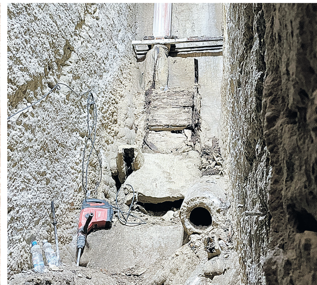
Parallel zur Holzbeschaffung galt es, den alten Radraum vom während Jahrzehnten gewachsenen Kalk zu befreien.
