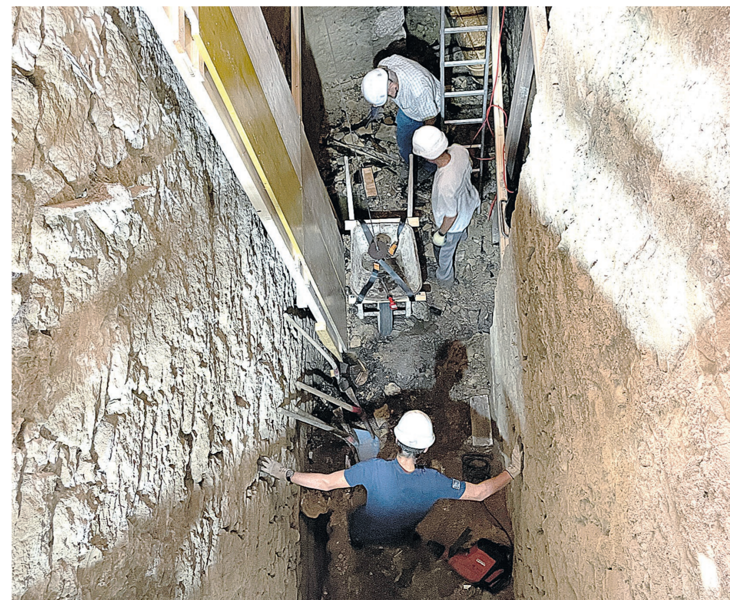
380 Schubkarren oder 23 Kubikmeter Kalk wurde dabei weggespitzt und zusammengeschaufelt.
