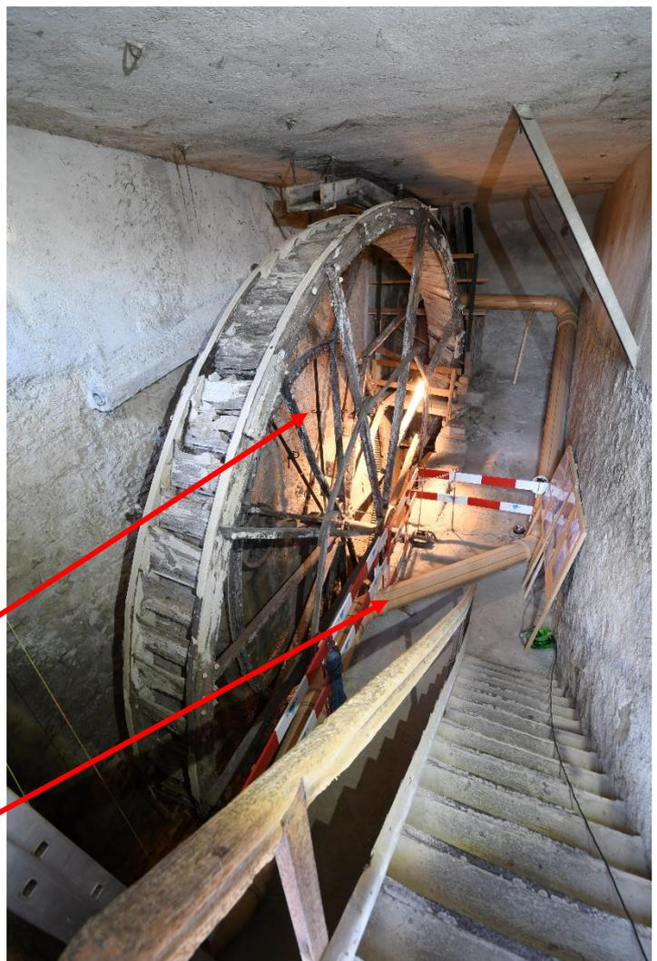
Im Jahr 2015 wurde als Sofortmassnahme der Innenzahnkranz aus Stahl (ca. 1.8 Tonnen) mit Stahlpriessen abgestützt.
