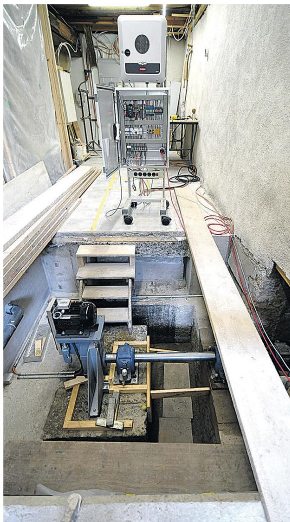
Im Vordergrund der durch das Wasserrad angetriebene Generator mit Antriebswelle, direkt dahinter der Schaltschrank mit Steuereinheit, Gleichrichter und Solar-Inverter.
